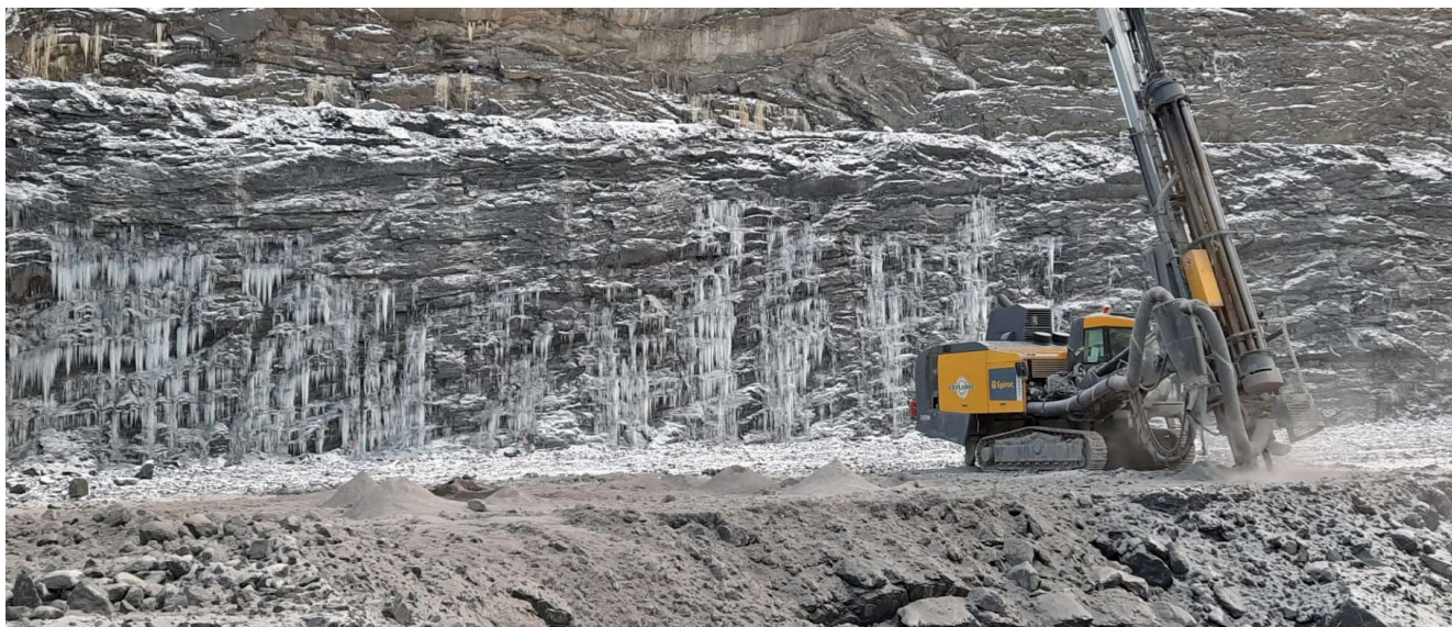
Foreuse fond de trou d'Exploroc à la carrière des Limites.
